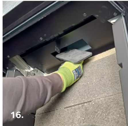
Poista etummainen tulenohjauslevy, sekä nuohousluukku tulipesän yläosasta. Huom! Sierassa on lukitusklipsi, joka pitää avata. Nuohoa tulisijan etukanavat sekä takakanavat nuohousluukun kautta.
