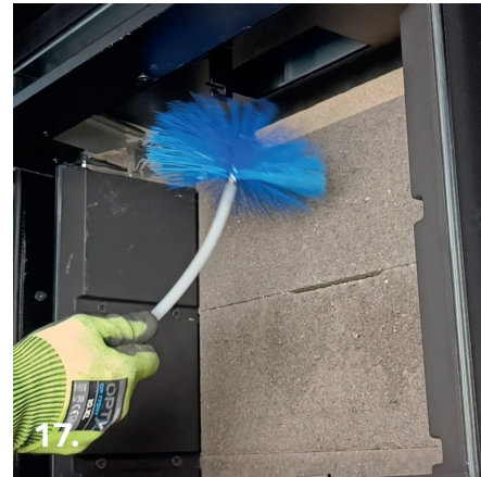
Poista etummainen tulenohjauslevy, sekä nuohousluukku tulipesän yläosasta. Huom! Sierassa on lukitusklipsi, joka pitää avata. Nuohoa tulisijan etukanavat sekä takakanavat nuohousluukun kautta.
