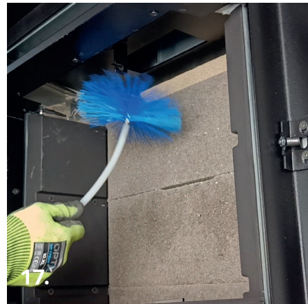
15. 16. 17. Fremste baffelplate og feieluke skal fjernes fra overdelen av ildsted. Merk! Siera er utstyrt med en låseklips som må åpnes. Front- og bakkkanaler på ildsted skal feies gjennom feieluken.
