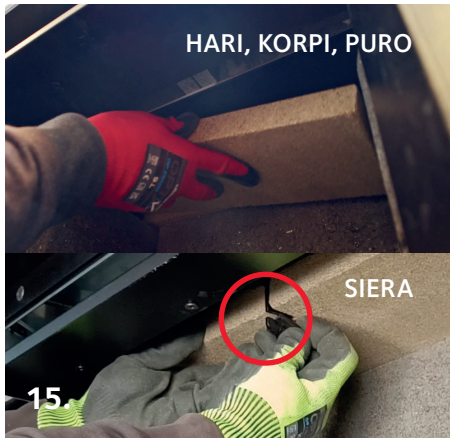
15. 16. 17. Fremste baffelplate og feieluke skal fjernes fra overdelen av ildsted. Merk! Siera er utstyrt med en låseklips som må åpnes. Front- og bakkkanaler på ildsted skal feies gjennom feieluken.
