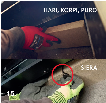
Poista etummainen tulenohjauslevy, sekä nuohousluukku tulipesän yläosasta. Huom! Sierassa on lukitusklipsi, joka pitää avata. Nuohoa tulisijan etukanavat sekä takakanavat nuohousluukun kautta.
