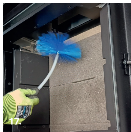
Eemalda esimene tulesuunaja ja puhastusluuk tulekolde ülaosast. Tähelepanu! Sieral on lukustusklamber, mis tuleb avada. Pühi küttekolde esimesed ja tagumised kanalid puhastusluugi kaudu.
