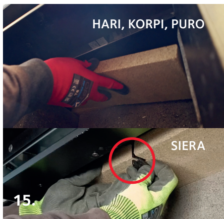
Eemalda esimene tulesuunaja ja puhastusluuk tulekolde ülaosast. Tähelepanu! Sieral on lukustusklamber, mis tuleb avada. Pühi küttekolde esimesed ja tagumised kanalid puhastusluugi kaudu.
