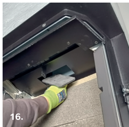
Eemalda esimene tulesuunaja ja puhastusluuk tulekolde ülaosast. Tähelepanu! Sieral on lukustusklamber, mis tuleb avada. Pühi küttekolde esimesed ja tagumised kanalid puhastusluugi kaudu.
